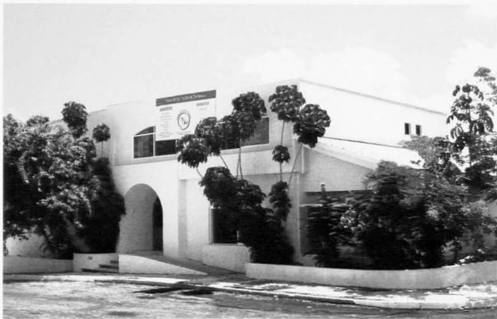
Casa de la Cultura Jurídica en Cancún, la segunda en el Estado de Quintana Roo.
