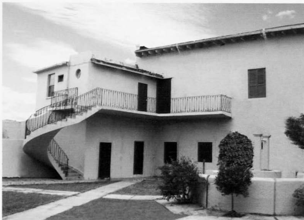
Junjón y fachada posterior de la Casa en Matamoros.
