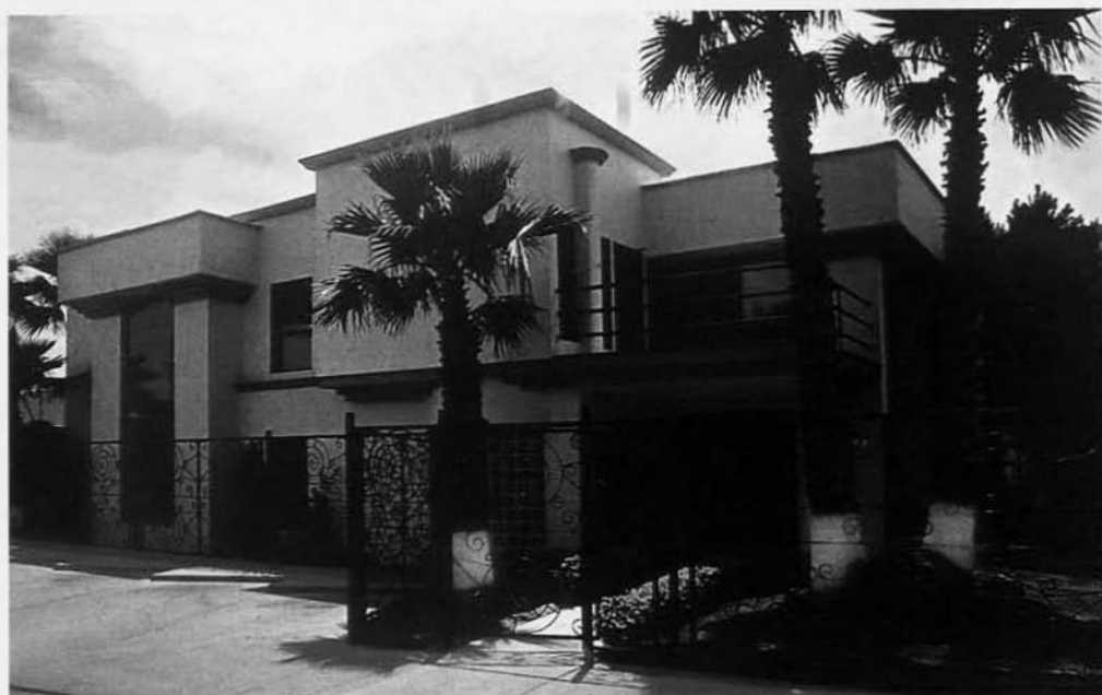
Casa de la Cultura Jurídica en Ciudad Juárez, construida en los años sesenta del siglo XX. Páginas iniciales: El audaz diseño de líneas contemporáneas se conjuga con la sobriedad del edificio principal.
