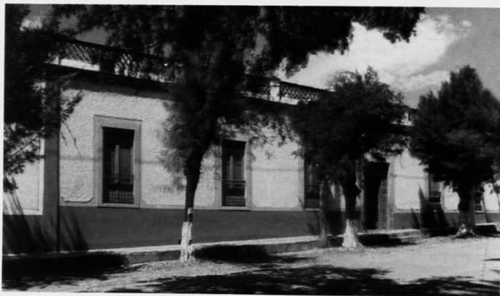
En la tradicional avenida Paseo de la Presa se ubica la Casa de la Cultura Jurídica en Guanajuato, que se ve aquí antes de su restauración. Páginas previas: el patio es uno de los elementos característicos del inmueble que aloja a la Casa de la Cultura Jurídica de Guanajuato. Enfrente, la fuente manierista de la vieja casona luce como en sus mejores tiempos. Páginas siguientes: los típicos cerros del real minero de Guanajuato enmarcan una arquitectura que ha visto dos centurias de historia.
