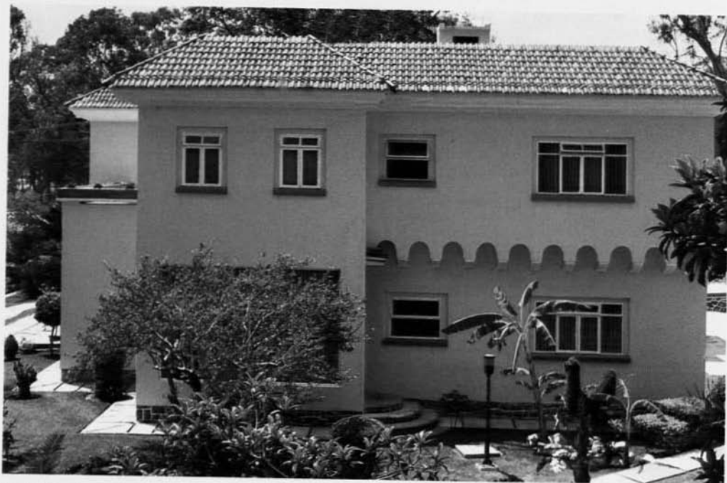
En la falda de los cerros de Loreto y Guadalupe se ubica la Casa de la Cultura Jurídica de Puebla. Páginas previas: Entre áreas jardinadas, una combinación de elementos arquitectónicos tradicionales y modernistas.
