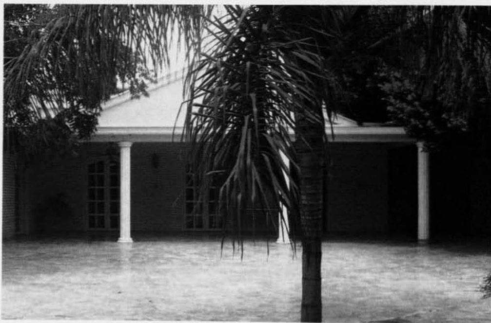
La nueva sede de la Casa de la Cultura Jurídica de Torreón. Páginas previas: Portada del edificio que ocupa actualmente la Casa de la Cultura Jurídica de Torreón.
