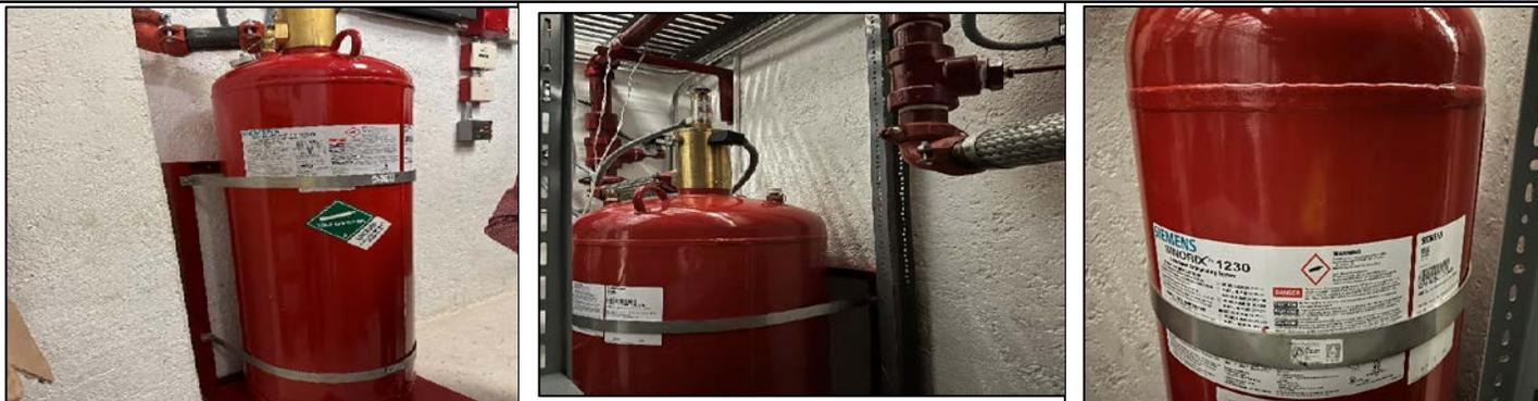
En las fotografías se puede observar la instalación y funcionamiento de los tanques contenedores del agente extintor tipo SINORIX 1230.
