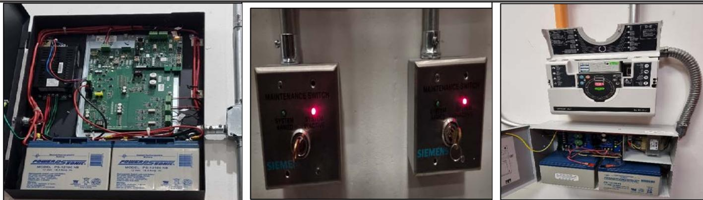
En las fotografías se puede observar la instalación y funcionamiento de las fuentes de poder auxiliares, interruptores de mantenimiento marca SIEMENS y unidad de detección temprana mediante aspiración marca VESDA.
