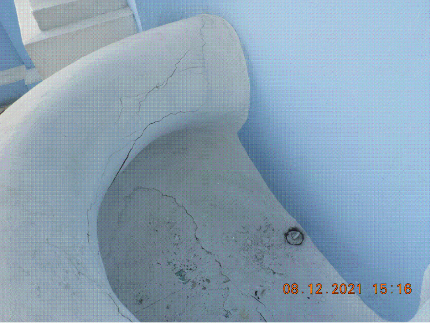
FISURAS EN LA FUENTE DEL ACCESO
