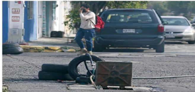
En la red hidráulica se han detectado tomas clandestinas en las que se instalan mangueras y bombas para llevar el agua a puntos de almacenaje.
