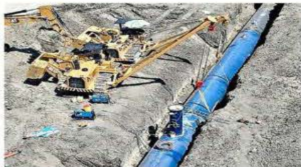
Un segmento del ducto, atrás de la Refinería de Cadereyta, es sostenido por dos grúas para apenas ser unido ayer.
