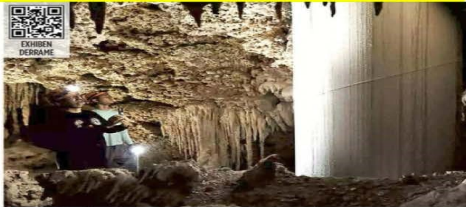
El tramo detenido es donde se encuentran ríos subterráneos y los cenotes que se han perforado para colocar columnas de cemento.
