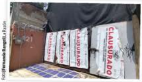
AVISO de suspensión en la obra, ayer.
