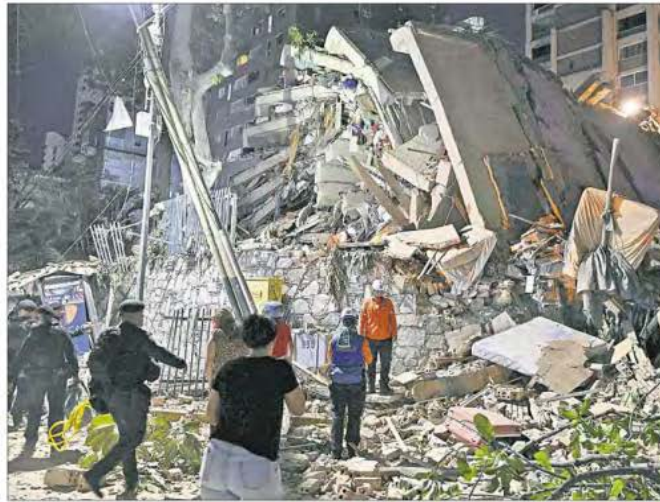
▲ Los dos movimientos telúricos continuos en el estado de Carabobo dejaron múltiples edificios derruidos en varias ciudades en la región centro-norte del país, incluida la
