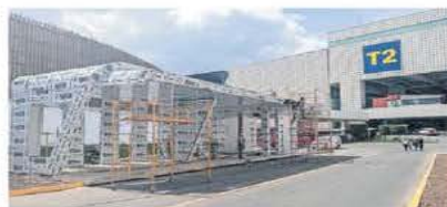
En la Terminal 2 del Aeropuerto Internacional Benito Juárez de la Ciudad de México aún se ven obras en proceso.
