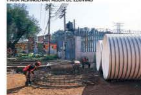
Construyen tanques tormenta para evitar inundaciones sobre Zaragoza
