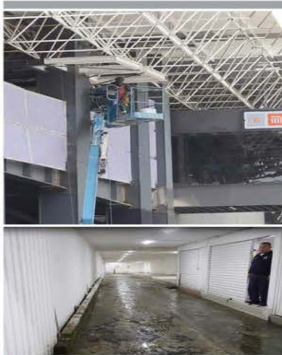
En bajopuentes y estaciones del Metro siguen las obras.
