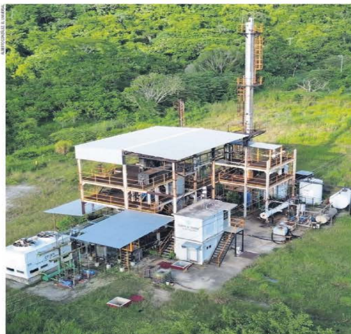
La minirrefinería asegurada en 2025 en Coatzacoalcos actualmente se ve abandonada y sin ser desmantelada.
